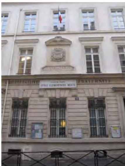
Fig. 5 École primaire Boulangers 19 Rue des Boulangers, 75005 Paris, France
