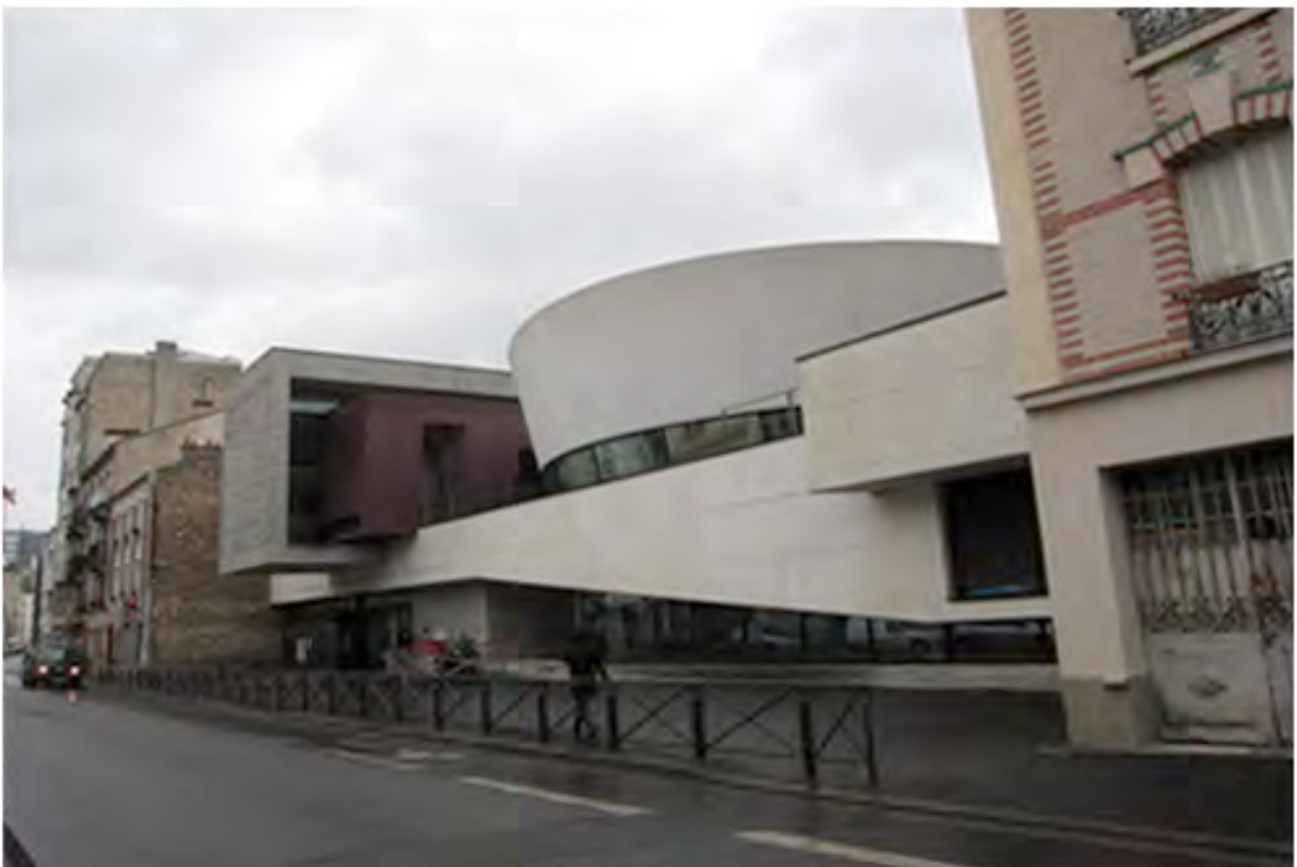
Fig. 10. Facade of the Groupe Scolaire Guy Môquet
